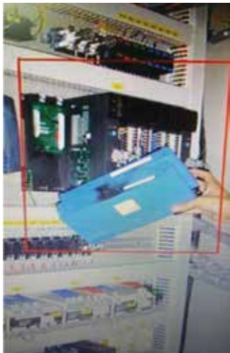
■ 서지유입으로 인한 제어반 소손 SPD를 적용하였으나 부적절한 사양의 SPD를 적용하여 서지유입시 제대로된 보호를 받을수 없어 발생한 사고로 사전에 정확한 진단을 통하여 규격에 맞는 제품을 사용하여야 한다.
