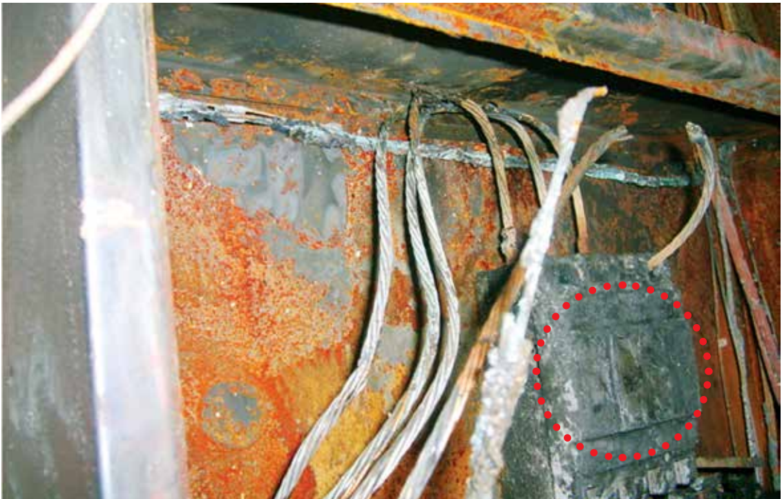
■ 낙뢰서지로 인한 전위차 발생 낙뢰가 발생되어 순간적인 전위차 상승으로 인한 화재사고로 이를 방지하기 위해서는 접지설비 보완과 SPD설비 보완이 이루어져야 한다.
